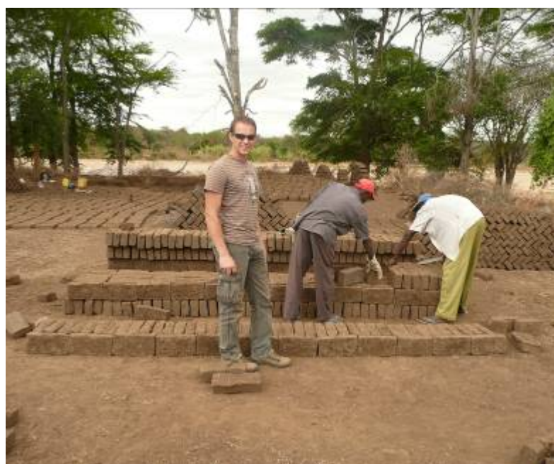
Foto 3 Het opstapelen van de stenen is precisiewerk
